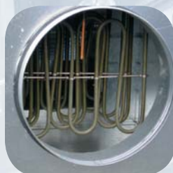
Нагревательные элементы из нержавеющей стали
